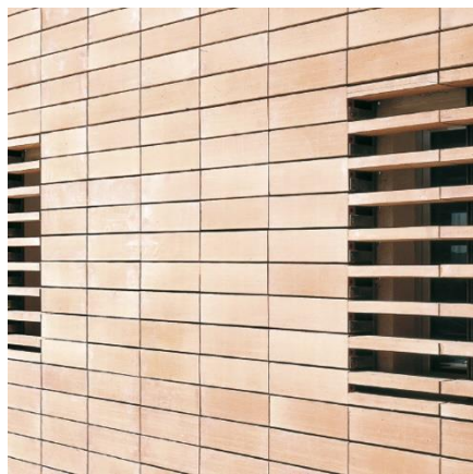
Facciata ventilata "Doga con kerf" Sannini Impruneta, con elementi frangisole in prossimità delle aperture.
