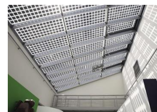
Lucernaio con vetri fotovoltaici
